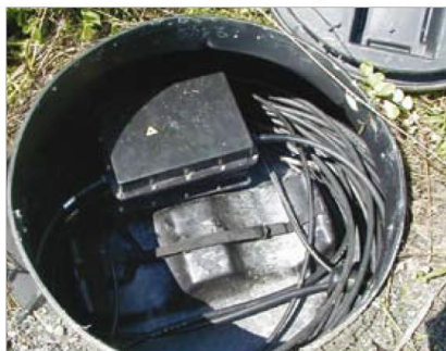
České dráhy: Uložení na trase bez jeřábu.
