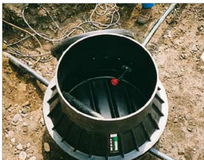
Energie AG Oberösterreich: Zafouknutí dodatečného optického kabelu.
