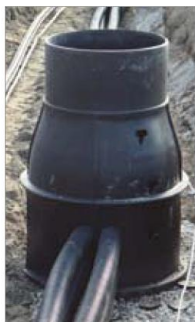
Komunální výstavba cest
