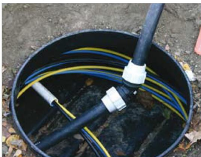
Připojení optických kabelů pomocí PLASSON kolena 45°.
