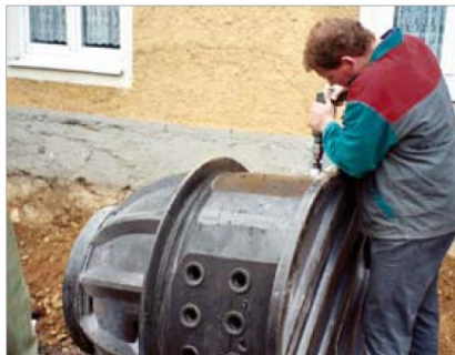
Napojení trubek a montáž těsnění na místě.
