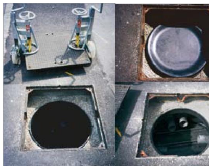
Těsný poklopatý systém s oddělenou těsnicí a nosní funkcí.
