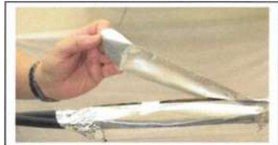
3b. Längsskeletverbindung JML wird mit dem Band JAT50 überklebt
