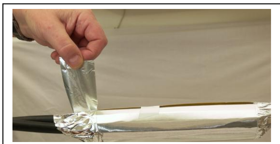
3a. Okraje aluminiové kostry JML se přelepí páskou JAT50
