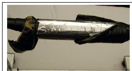
7b. Ke znovu uzavření spojky není nutné odstraňovat zbytky otevřeného pláště
