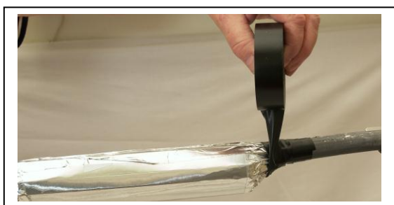
4. První vrstva pásky J51 se po navinutí na kabel vine lepem vně (spojka se snadno otevřít)
