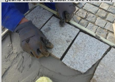
na lepidlo vyskládáme jednotlivé kameny
