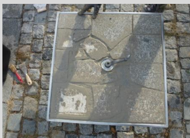
zarovnáme povrch víka a sundáme ochranné pásky, zbytky lepidla pečlivě očistíme
