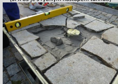
kameny lehce do lepicí směsi zaklepeme gumovou paličkou a kontrolujeme jejich polohu ve víku
