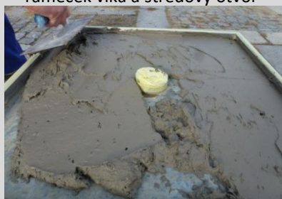
nanesení lepidla stěrkou do výšky podle připraveného vkládaného kamene pro výplň
