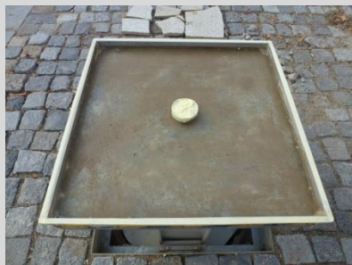
vyčistíme víko a zalepíme ochrannou páskou nerezový rámeček víka a středový otvor
