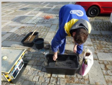
pro výplň víka řádně rozmícháme mrazuvzdornou lepicí směs (jedno balení 25 kg stačí na dvě velká víka)
