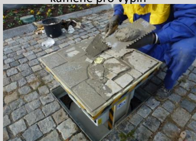
lepicí směsí vyplníme spáry mezi vloženými kameny
