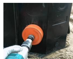
Ad.5. Vyřezání otvoru
