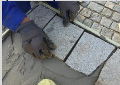
na lepidlo vyskládáme jednotlivé kameny
