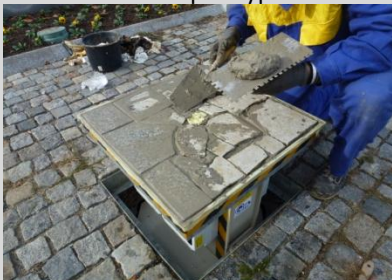
lepicí směsí vyplníme spáry mezi vloženými kameny
