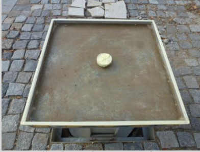
vyčistíme víko a zalepíme ochrannou páskou nerezový rámeček víka a středový otvor
