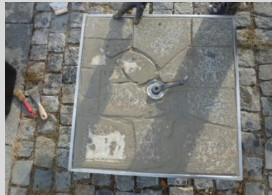
zarovnáme povrch víka a sundáme ochranné pásky, zbytky lepidla pečlivě očistíme
