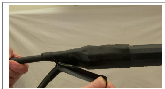
5e. Zajištění „kalhotek“ antikorozi páskou J51
