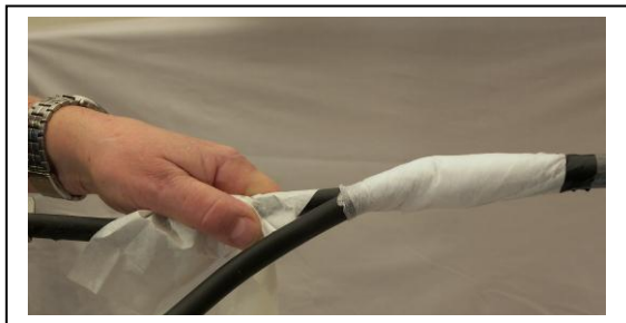
1. Očištění kabelu čistící tkaninou JCCIPA a stažení svazku polyesterovou netkanou textilií JNW170
